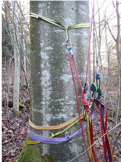
Zwei simple 1:2 Flaschenzüge zum Spannen einer Doppelseilbrücke
