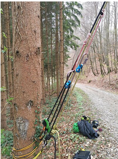
Zwei 1:2 Flaschenzüge zum Spannen einer doppelten Schrägseilbrücke
