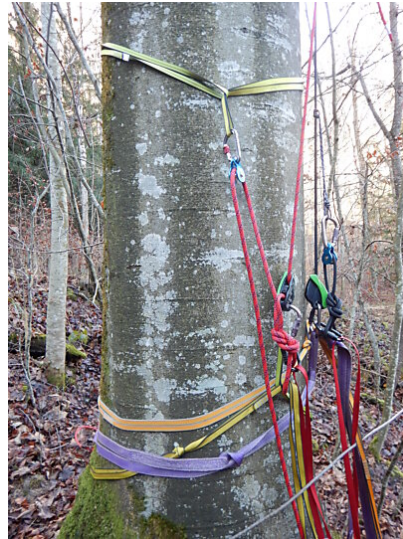
Zwei simple 1:2 Flaschenzüge zum Spannen einer Doppelseilbrücke
